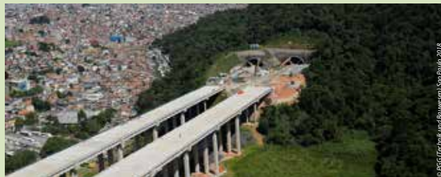
Obras no trecho norte do Rodoanel
