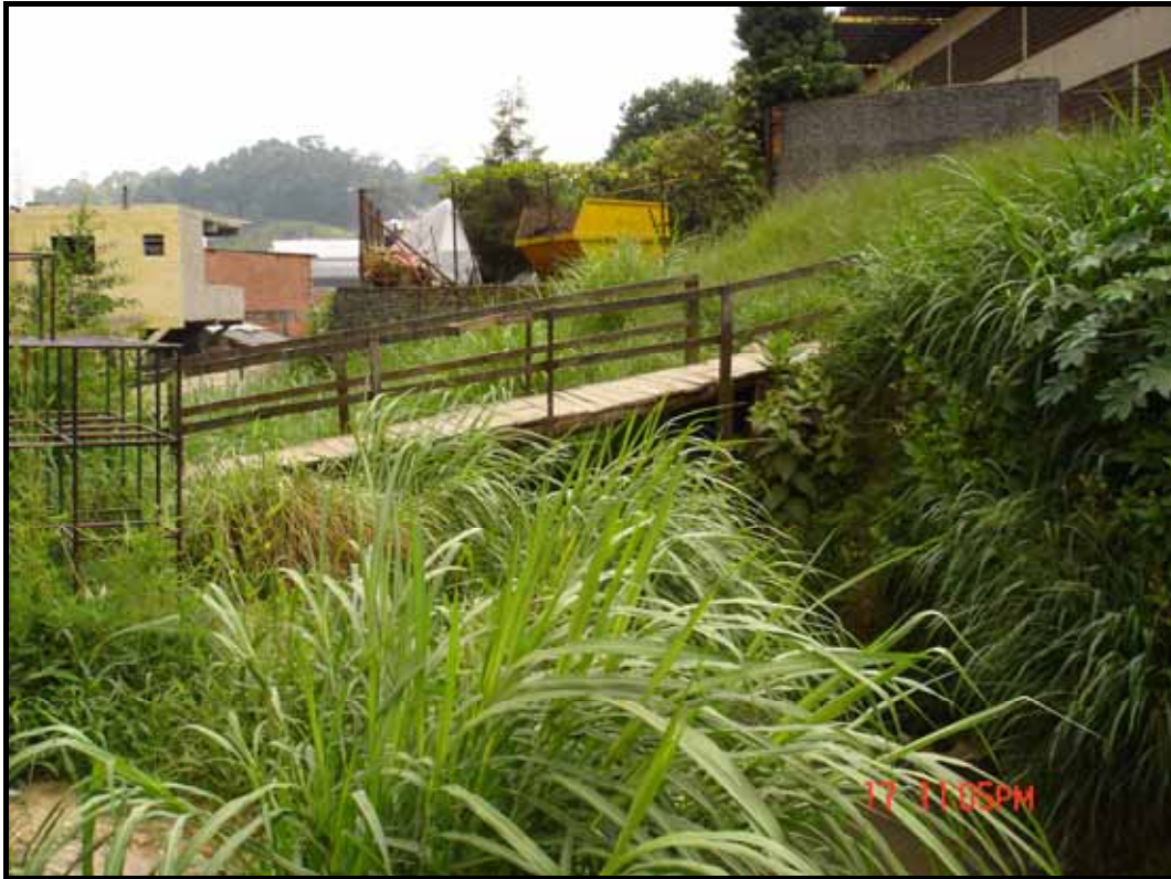
Foto 05 – Ponte sobre o trecho do córrego que não pode ser canalizado. Autor: Ribeiro, F.V. Jan/2006
