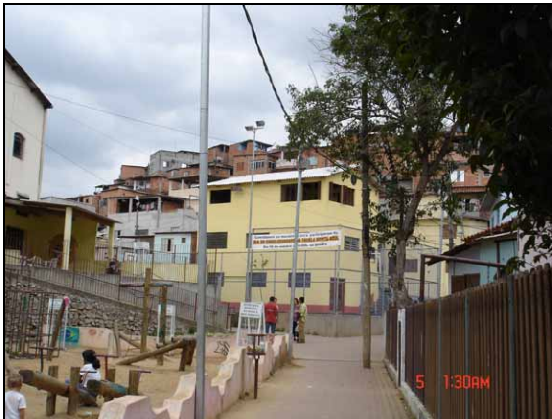
Foto 13: Ao fundo prédio da oficina de restauro e um grupo de voluntários estrangeiros. Nas laterais temos a presença das creches e do parque recreativo. Autor: Ribeiro, F. V. Out/2006.
