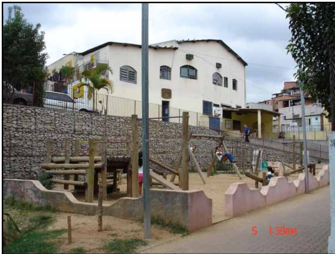
Foto 10: Prédio principal da ACMA na favela Autor: Ribeiro, F.V. Out/2006
