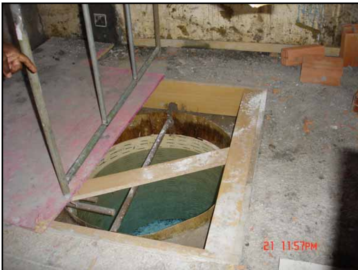
Foto 16: Sistema hidráulico de aproveitamento de águas oriundas das nascentes. Autor: Ribeiro, F.V. Mar/2006
