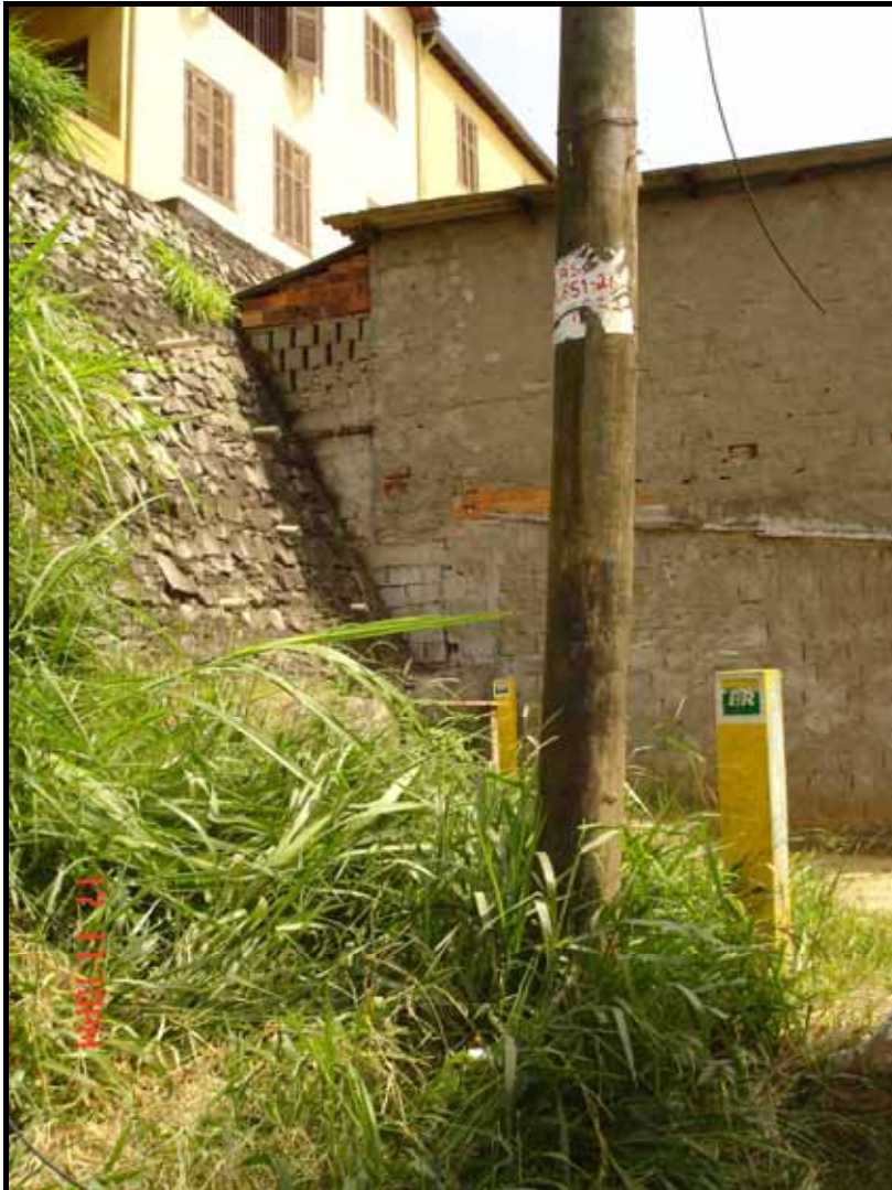
Foto 03 – Marcação da passagem do oleoduto existente sob a Favela. Autor: Ribeiro, F. V. Jan/2006
